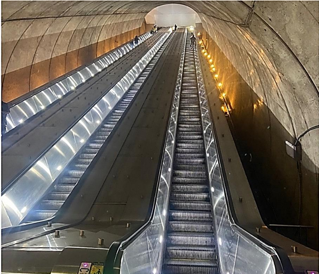
ワシントン DC の地下鉄は深度が深いことで有名です。中でも Wheaton 駅には全長 70m のエスカレーターがあり、途中に水平部分を持たないシングル・スパンエスカレーターとしては、西半球最長となっています。(写真は Bethesda 駅のエスカレーター)
