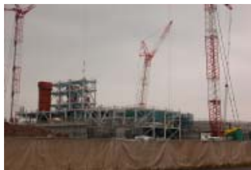
(建設中の処理施設本体)
