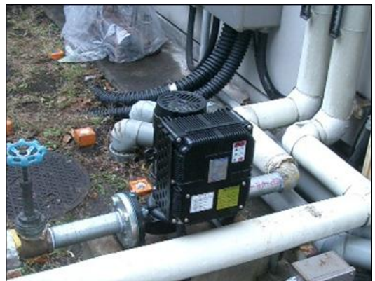
写真2 ポンプ設置状況
