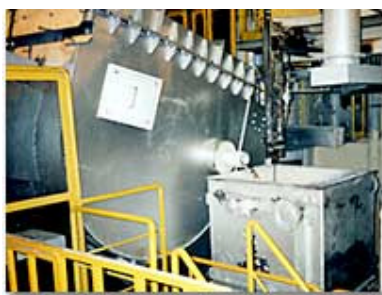
写真5 新開発バーナー搭載可傾炉
